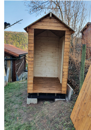
Aufbau des neuen Toilettenhäusles im Vereinsgarten
